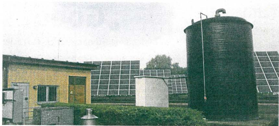
Alte Kläranlage und neuer Solarpark: Eine Pumpstation und ein unterirdisches Becken der alten Kläranlage werden am Grünen Weg auch weiterhin von der Stadt in Betrieb gehalten.
